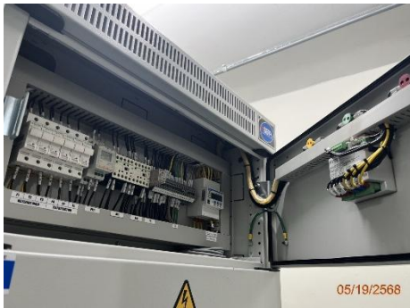
ภาพที่ 2.2-65 อุปกรณ์ปรับความเร็วรอบมอเตอร์ VSD
